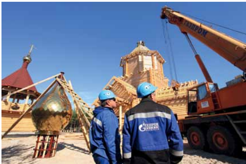
На строительной площадке Центра духовно-нравственного развития (Ноябрьск)
