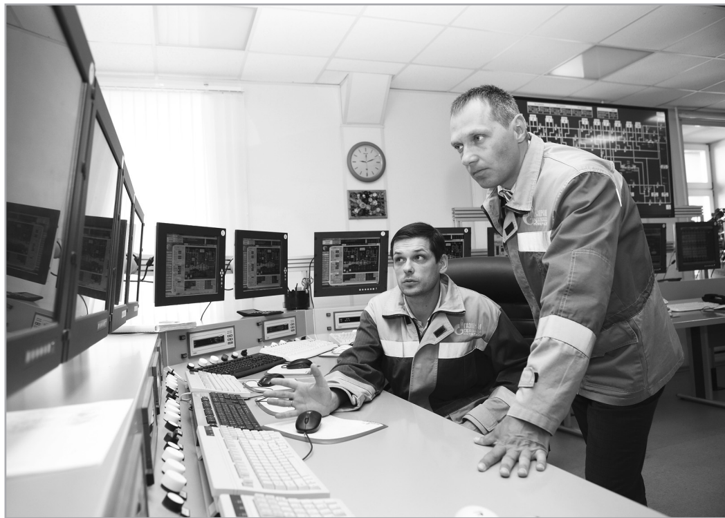
Справа налево: на главном щите управления ГПП С. В. Шашмулин, начальник Губкинского газового промысла и С. Ю. Тюрин, сменный инженер газокомпрессорной службы.
