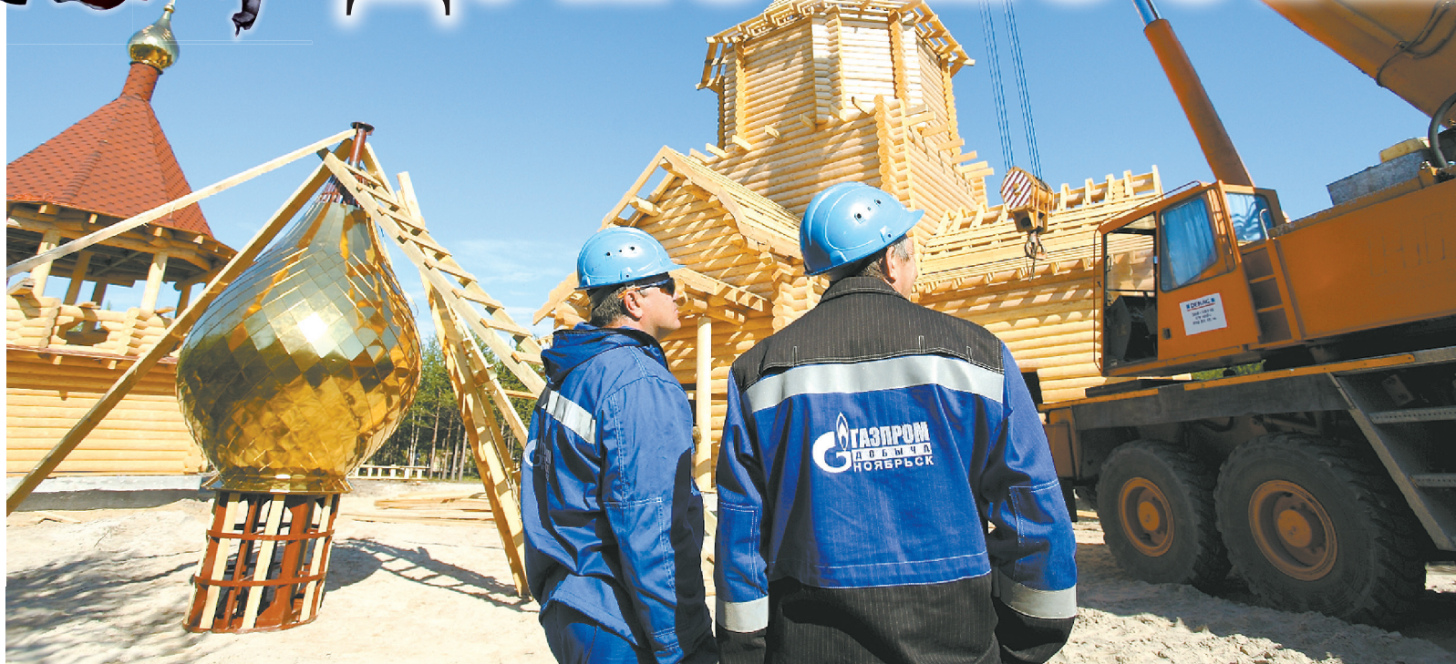
Один из этапов строительства храмового комплекса ЦДНВ.
