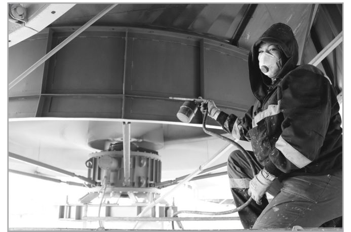
Айгуль Акбаева, маляр Комсомольского участка управления эксплуатации вахтовых поселков ООО "Газпром добыча Ноябрьск", производит окраску электродвигателя вентилятора аппарата воздушного охлаждения газа.
